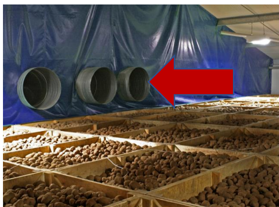
Figures 5&6 - Caisson de réfrigération d'un stockage en caisses et dépôt de CIPC dans un conduit de distribution d'air
